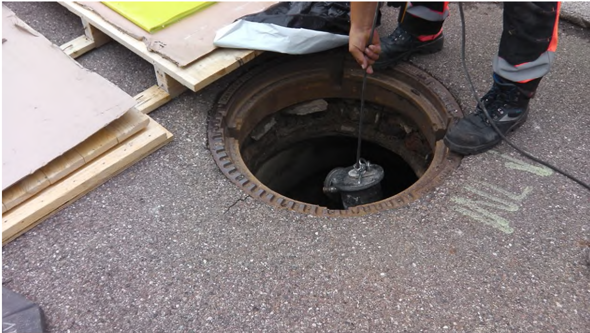
Bild 4: Einbau Inliner Bartenbach
