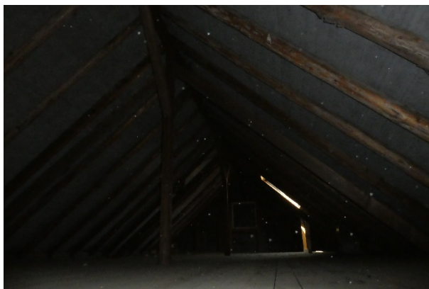
Ungedämmter Dachboden mit Dachgebälk ohne Hinweise auf Fledermäuse (keine Kot- oder Urinspuren)
