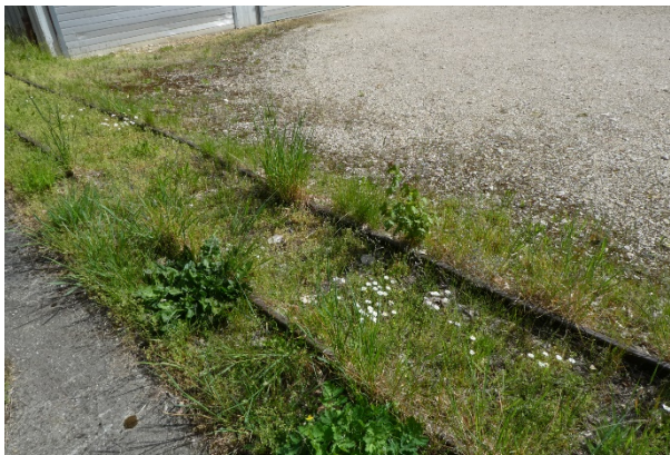
Transportschienen mit Anbindung an Werkstattgebäude 2. Stark verdichteter Untergrund mit Spontanvegetation.
