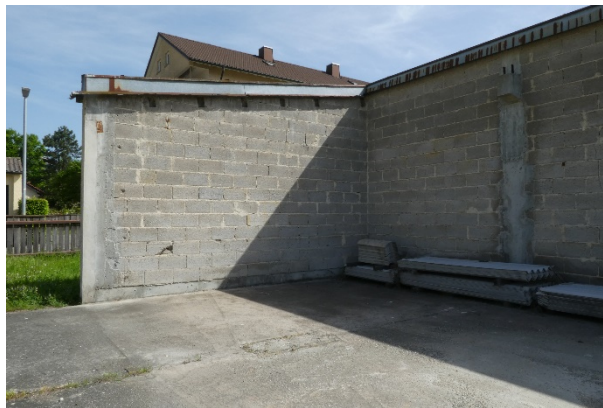
Gebäudereste mit Bodenplatte
