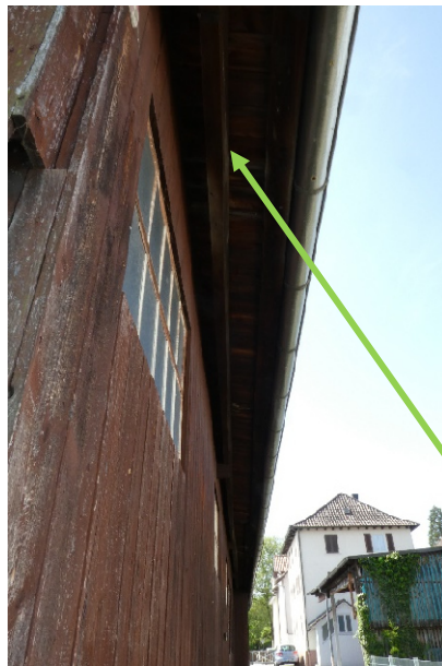
2-seitige Holzverkleidung (offener Anbau)
