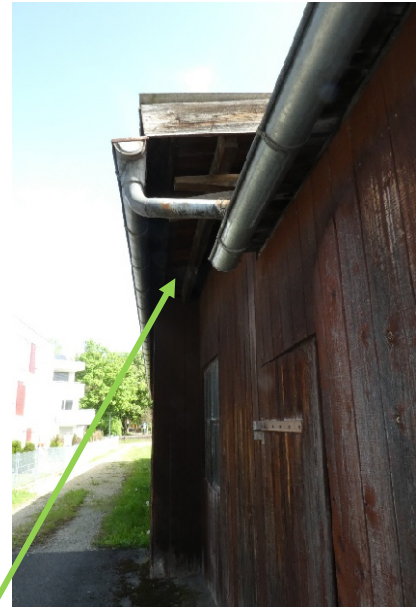
Offener Dachüberstand ohne Hinweise auf Nutzung durch Brutvögel oder Fledermäuse
