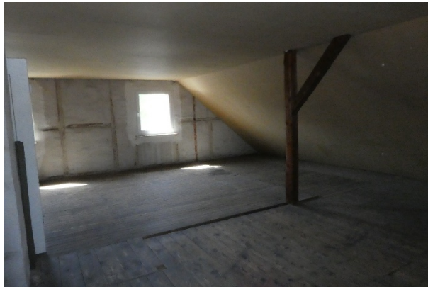
Ausgebautes Dachgeschoss ohne Zugangsmöglichkeit von außen
