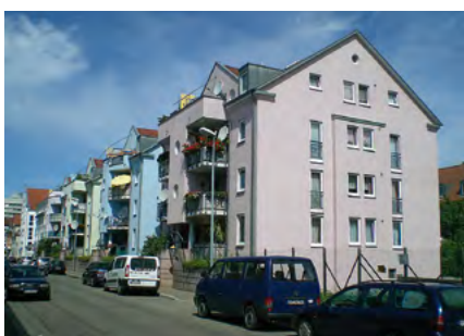
Innerstädtische Wohnstandorte im Bereich der Karlstraßen (oben) und in der Schützenstraße (unten)
