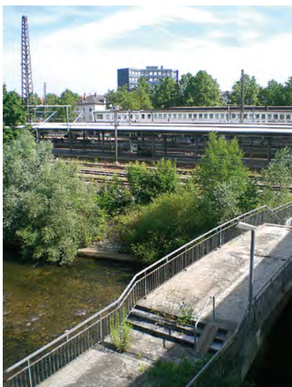
Die Uferbereiche der Fils sind im Innenstadtbereich nur schwer zugänglich.
