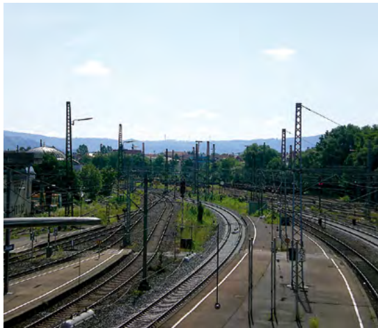
Weitere Querungsmöglichkeiten über die Gleisanlagen sollten geschaffen werden, um deren Trennwirkung zu reduzieren und die Ufer der Fils besser zugänglich zu machen.
