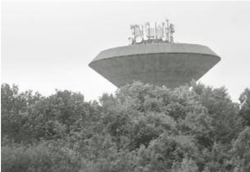
Der Wasserturm auf dem Eichert.
